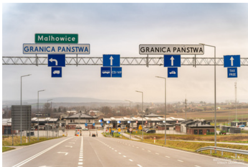
Fragment infrastruktury przejścia granicznego
