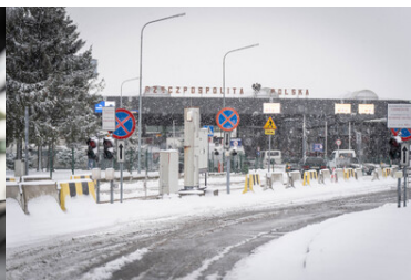
Fragment infrastruktury przejścia granicznego
