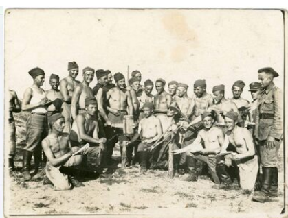
Po wykonanej pracy (tu po budowie zasieków na granicy) trzeba uwiecznić tych, którzy to robili.
